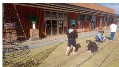
道の駅イルミネーション設置
